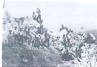
1953 - Si lavora per la strada di accesso al Santuario
